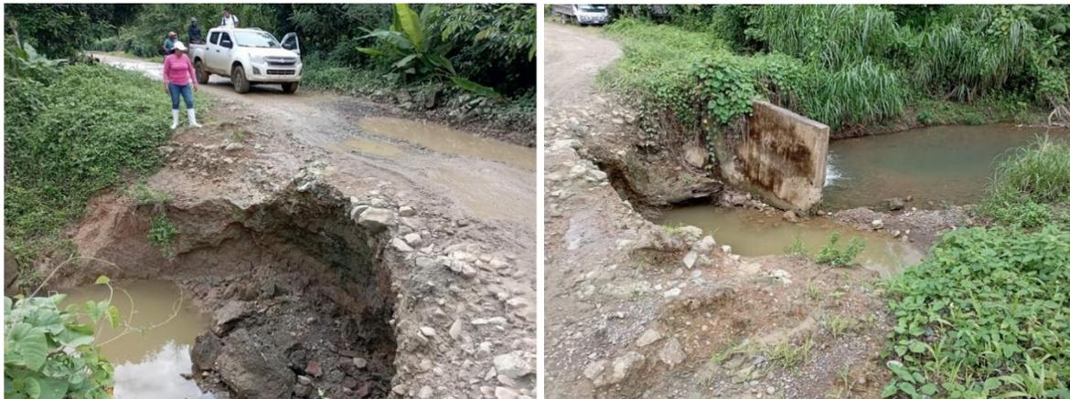
Estados de las vías en el trayecto E15 – Rompe. Socavones y alcantarillas en mal estado.
